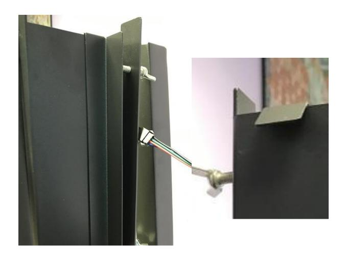
9- Installer et centrer la cible puis serrer les vis des équerres et les papillons sans forcer
